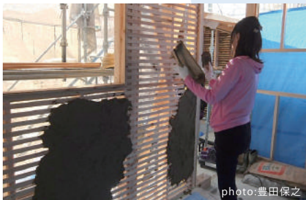
土壁の荒土塗り
