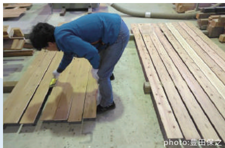
外壁板に柿渋塗料を塗装
