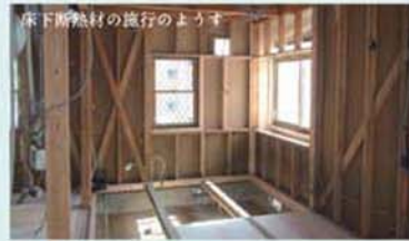
床下断熱材の施工の様子
